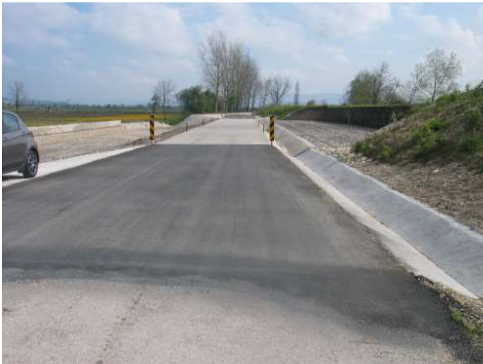
Estrutura de dissipação de energia do descarregador ECC 2 Obra concluída com a pavimentação da estrada
