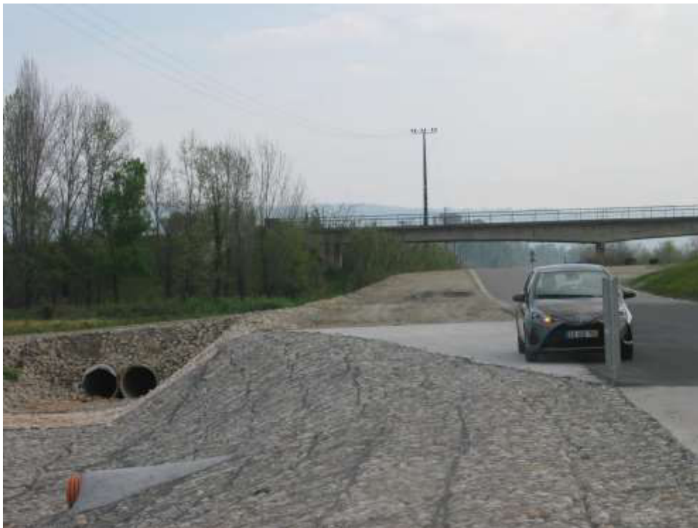
Estrutura de dissipação de energia do descarregador ECC 3 Obra concluída - Pormenor
