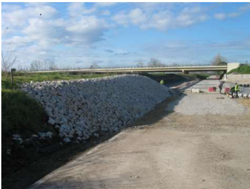
Estrutura de dissipação de energia do descarregador ECC 3 Início da colocação da base em tout-venant para pavimentação da estrada
