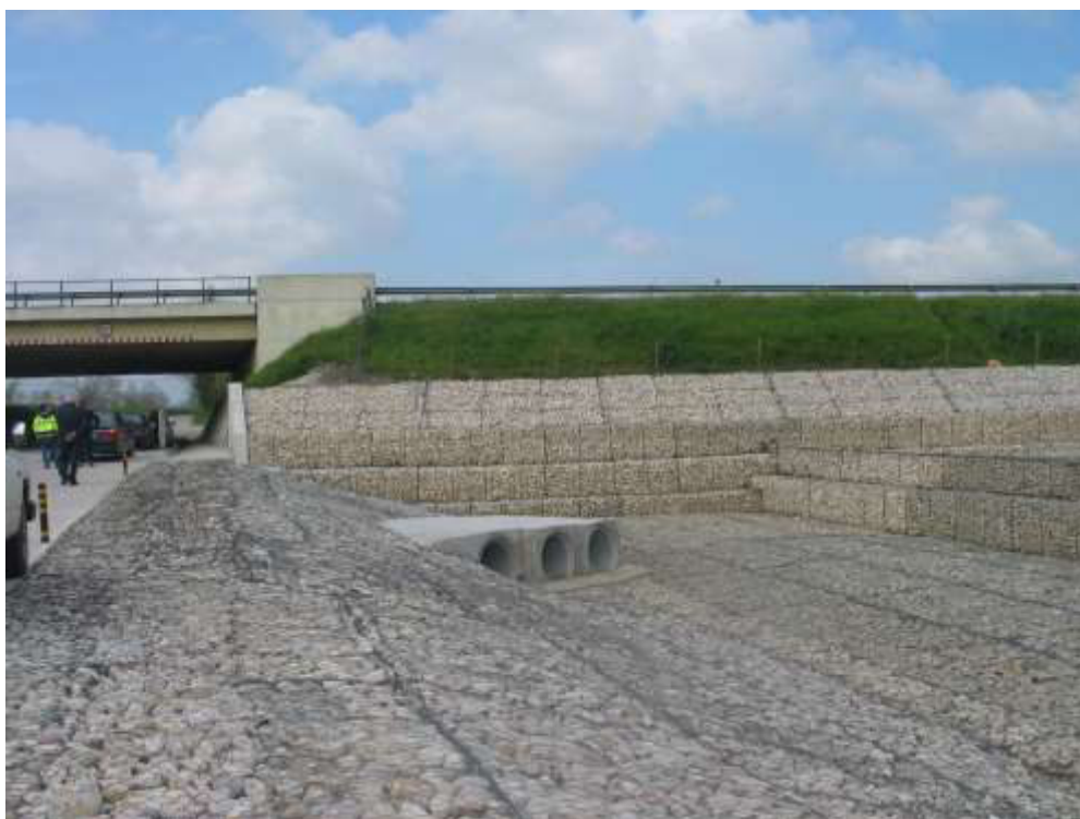
Estrutura de dissipação de energia do descarregador ECC 3 Obra concluída
