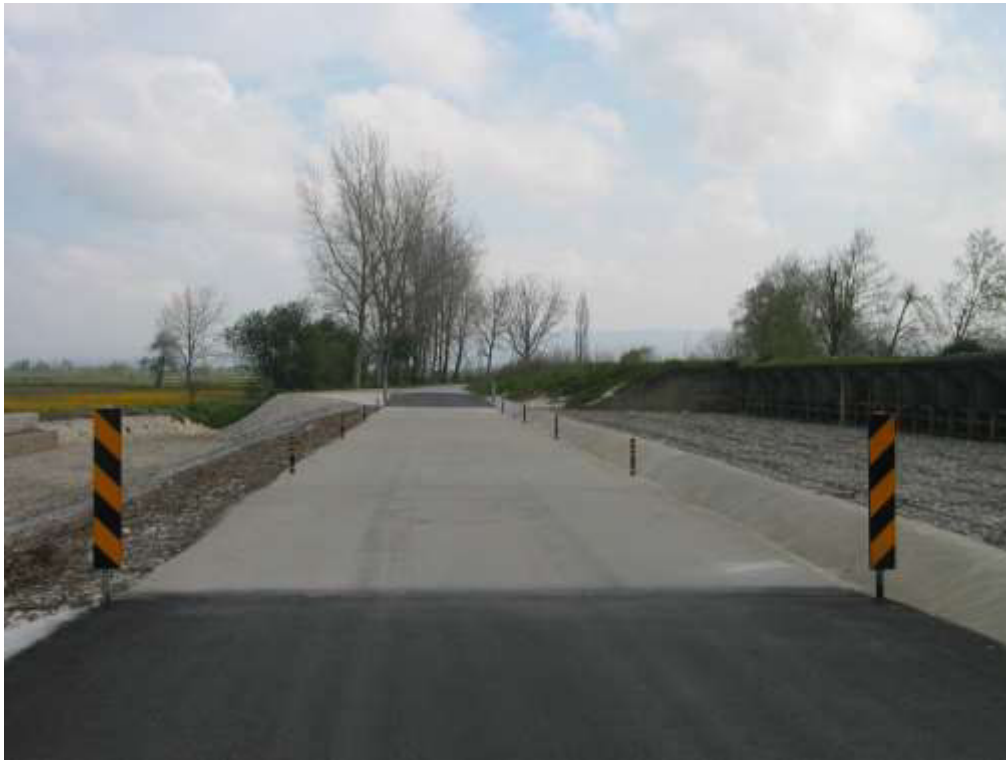
Estrutura de dissipação de energia do descarregador ECC 2 Obra concluída
