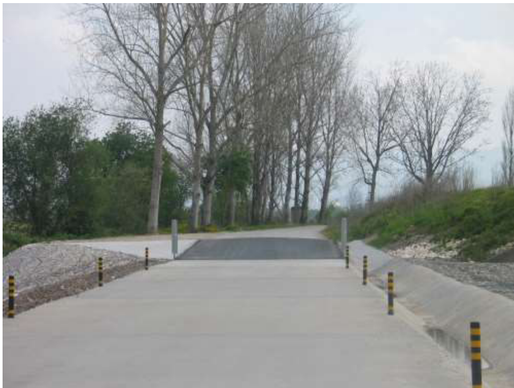
Estrutura de dissipação de energia do descarregador ECC 2 Obra concluída - Pormenor
