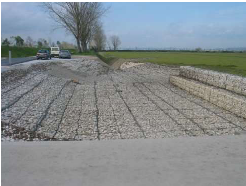
Estrutura de dissipação de energia do descarregador ECC 1 Obra concluída
