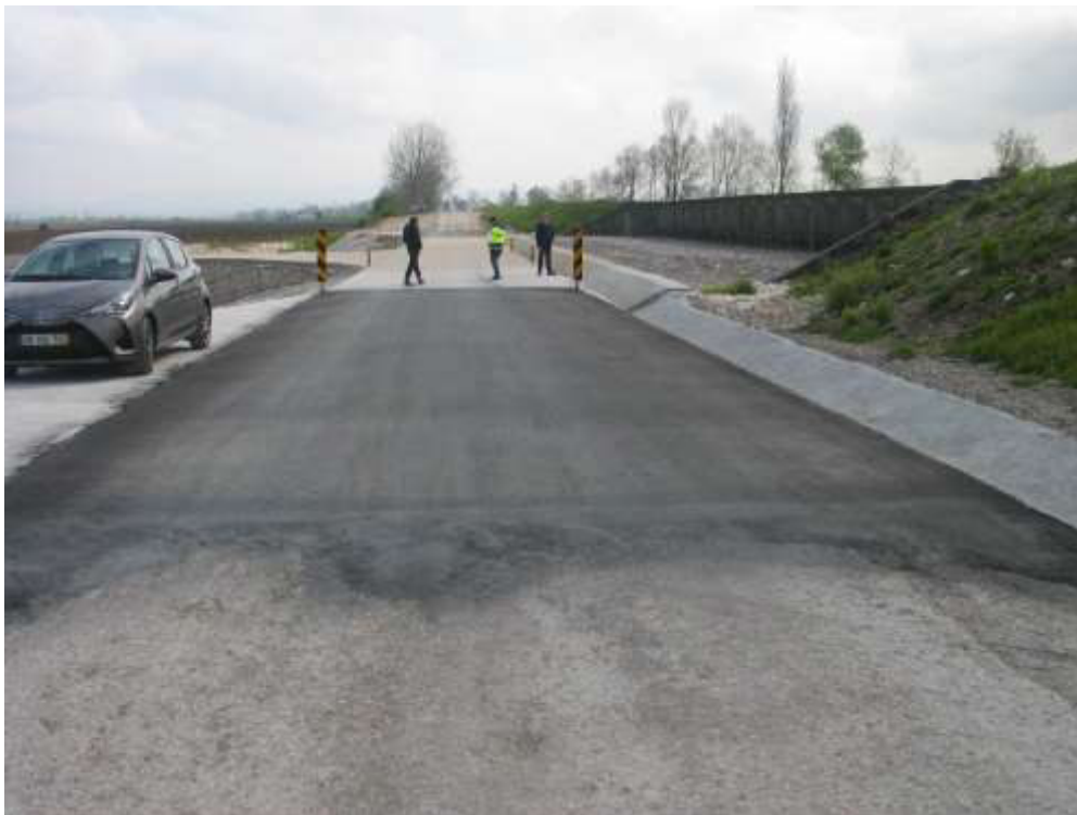
Estrutura de dissipação de energia do descarregador ECC 1 Conclusão da obra com a pavimentação da estrada
