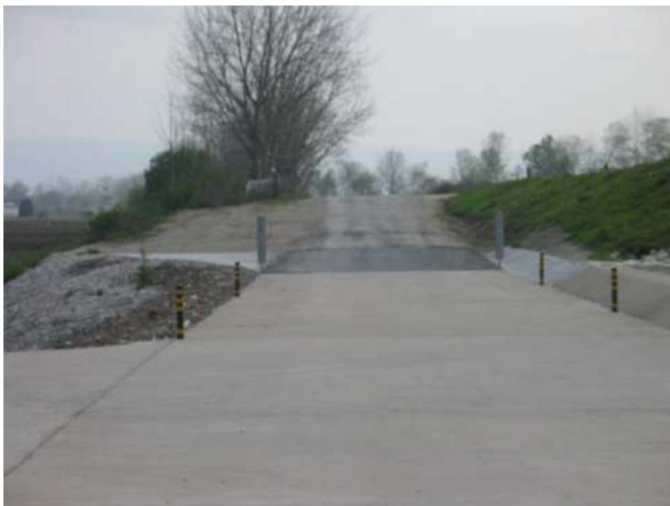
Estrutura de dissipação de energia do descarregador ECC 1 Obra concluída - Pormenor
