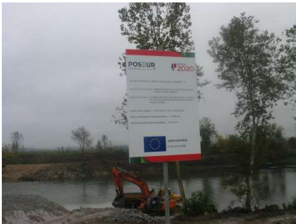
Reabilitação da soleira do perfil 115 do Leito Central do rio Mondego Painel de sinalização de execução de obra co-financiada pelo POSEUR
