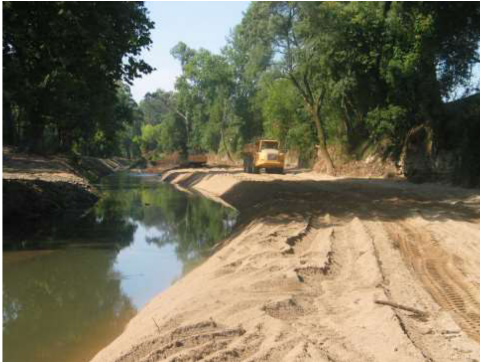
Aterro da plataforma do leito maior ( margem direita ) entre o viaduto da A1 e a travessia de s. João do Campo
