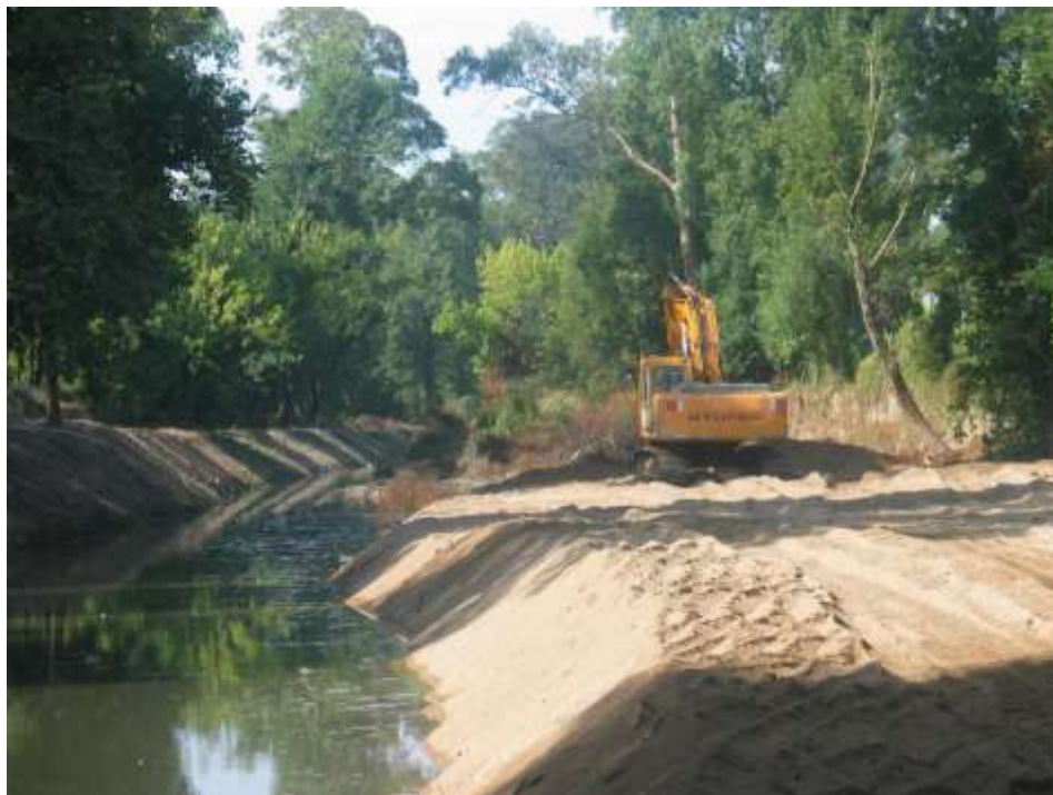
Aterro da plataforma do leito maior ( margem direita ) entre o viaduto da A1 e a travessia de s. João do Campo Pormenor
