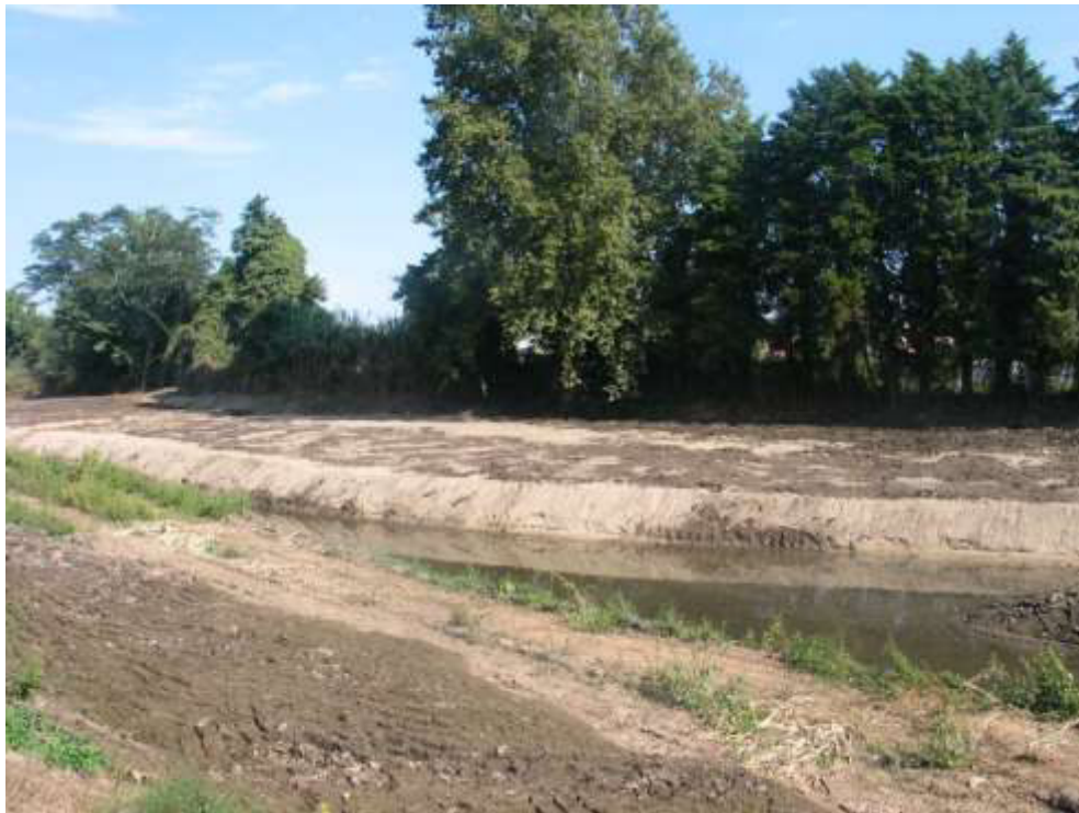
Aterro da plataforma do leito maior e desassoreamento do leito menor entre a EN 111 e a travessia do Loreto (concluídos)
