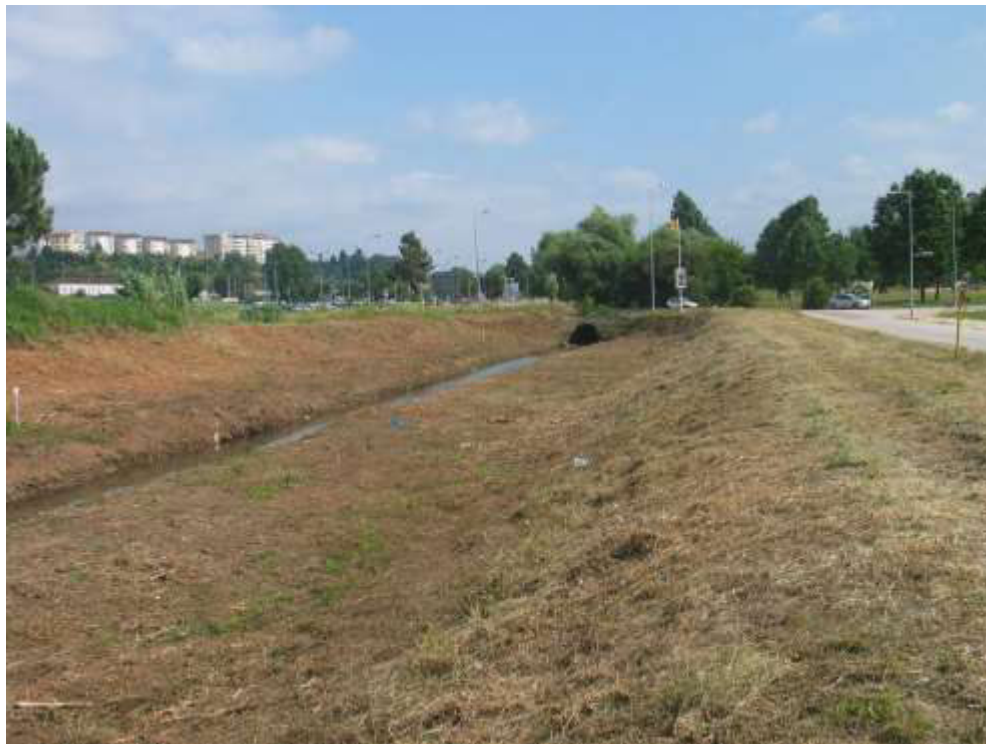
Limpeza de vegetação e desassoreamento do leito menor concluídos a jusante da travessia da EN 111 em Coimbra
