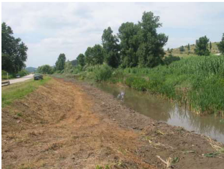
Desassoreamento do leito menor, a jusante da travessia do Loreto
