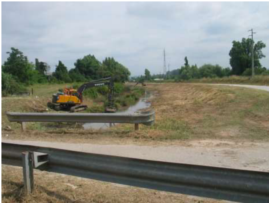
Execução do desassoreamento a montante da travessia do Loreto Vista para montante
