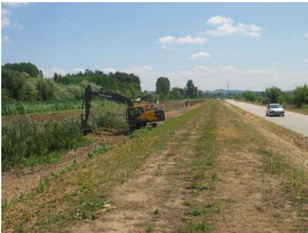
Execução do desassoreamento do leito menor a jusante da travessia da Pedrulha
