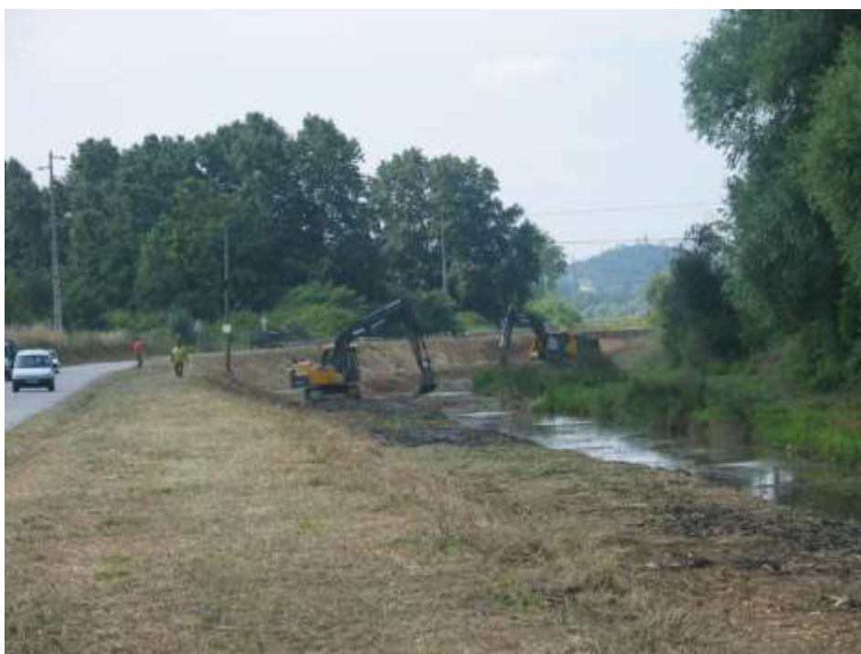
Execução do desassoreamento a montante da travessia do Loreto Vista para jusante
