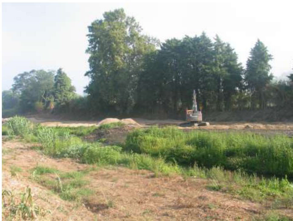
Íncio do aterro da plataforma da margem direita do leito maior entre a EN 111 e a travessia do Loreto
