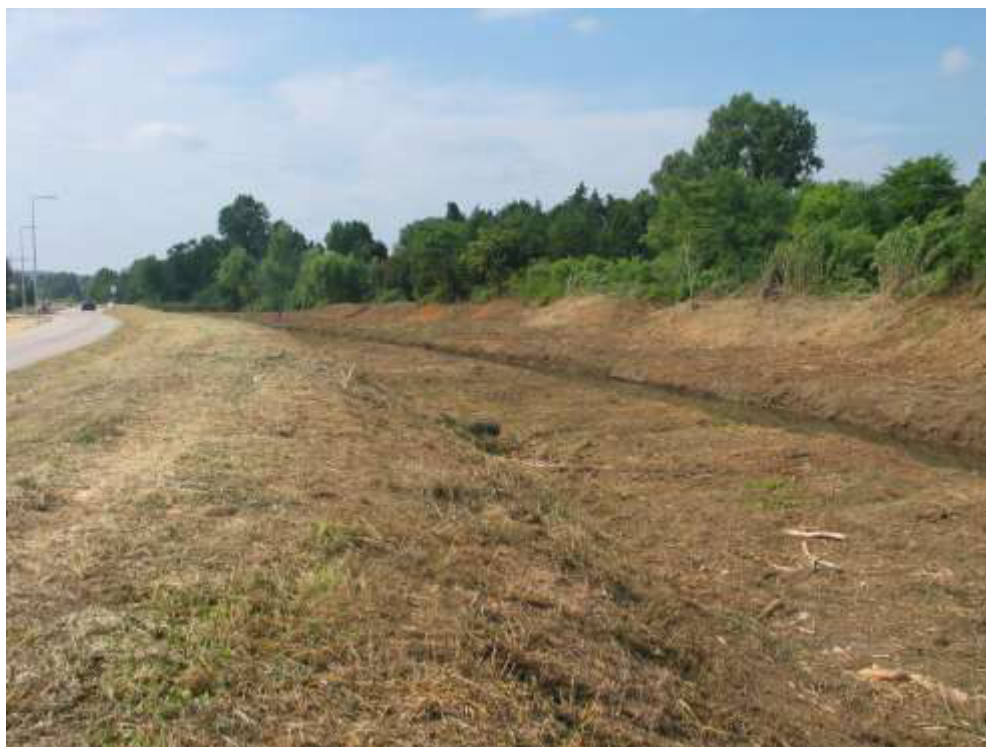
Limpeza de vegetação e desassoreamento do leito menor concluídos a jusante da travessia da EN 111 em Coimbra Vista para jusante
