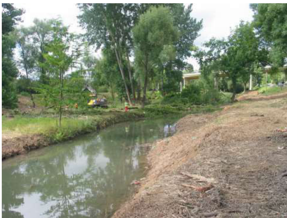
Limpeza de vegetação do leito e dique a montante da A1
