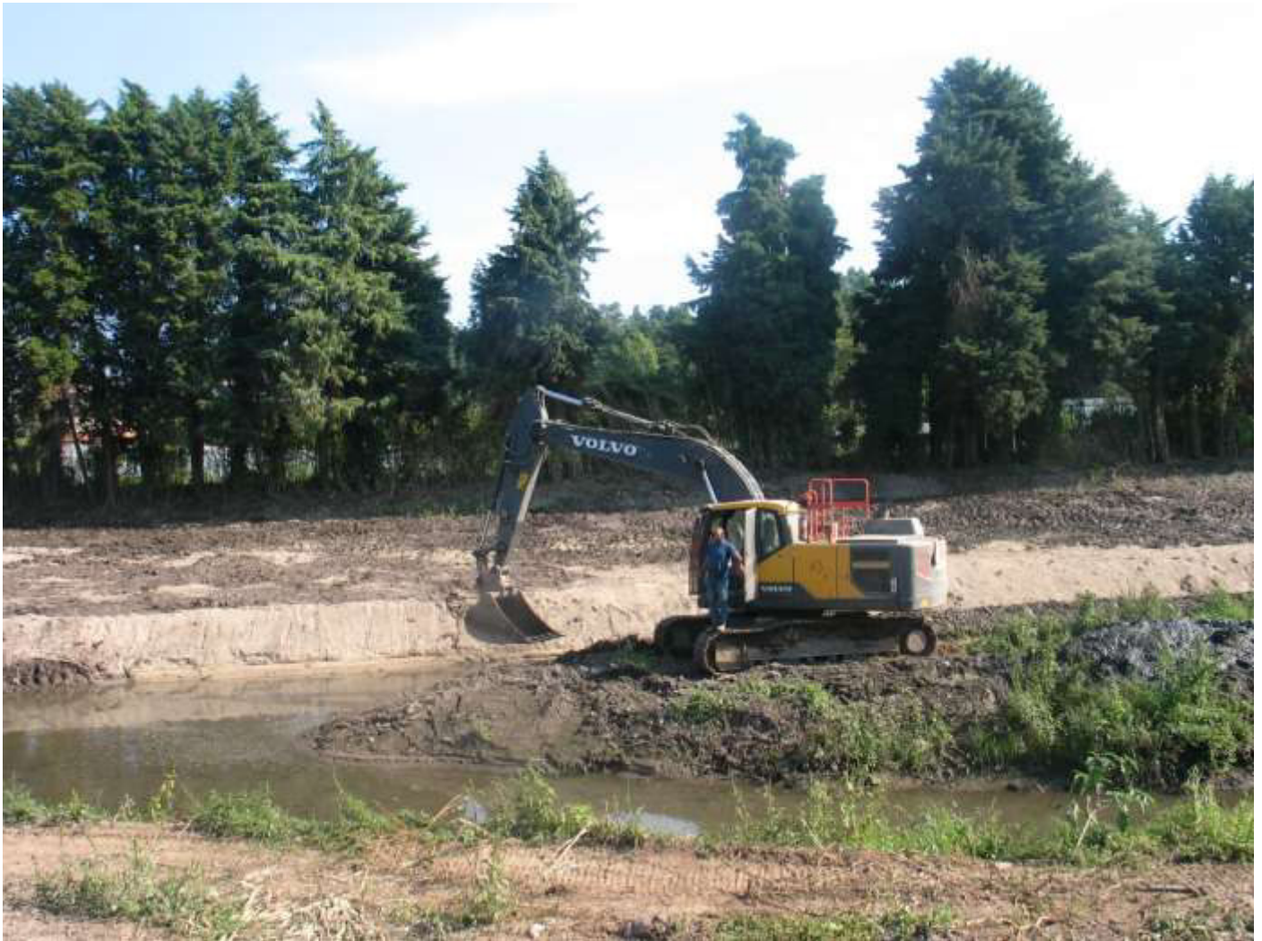
Aterro e desassoreamento concluídos na zona da confluência da Vala do Norte com o Leito Periférico Direito
