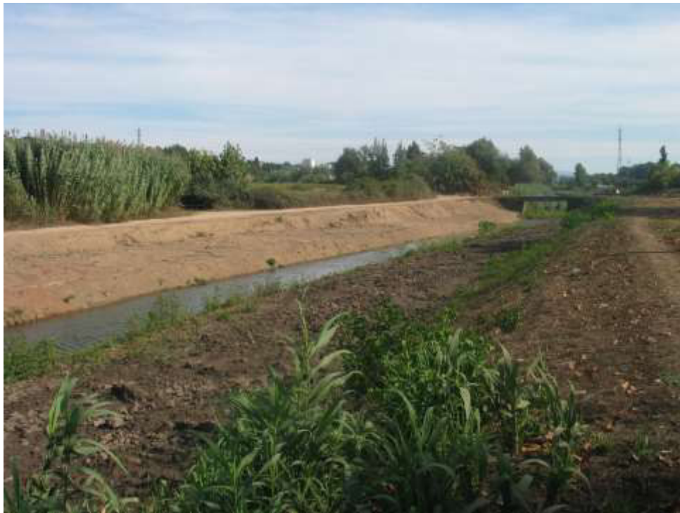
Aterro da plataforma do leito maior a jusante da travessia do Loreto (concluído) – Vista para montante
