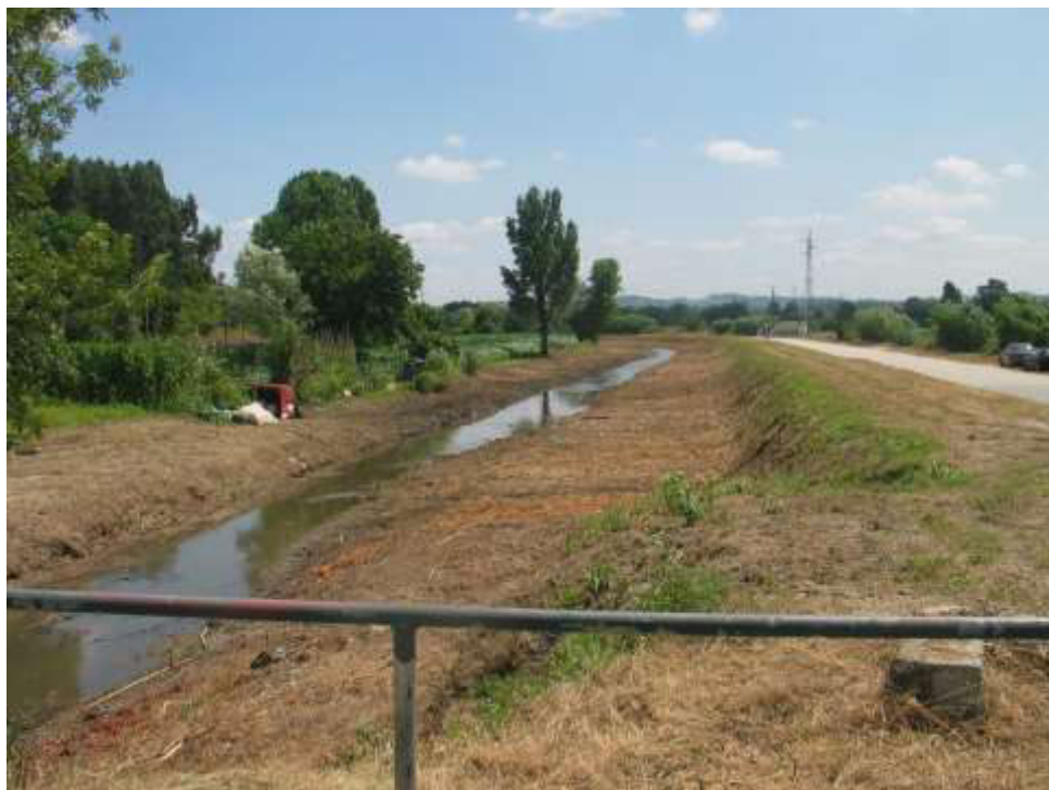
Limpeza de vegetação do dique e do leito concluídos a montante da travessia da Pedrulha
