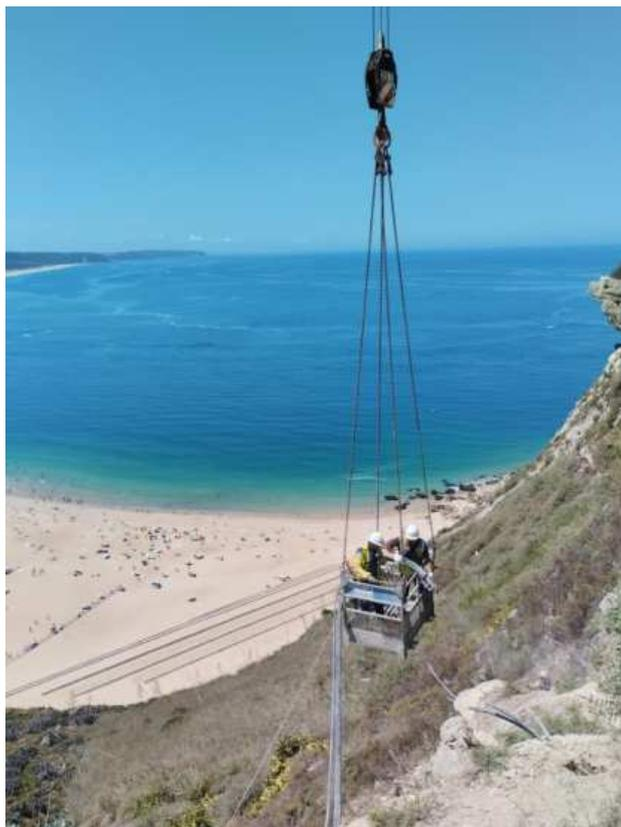
Foto 5 – Execução de trabalhos de projeção de betão no pano do talude
