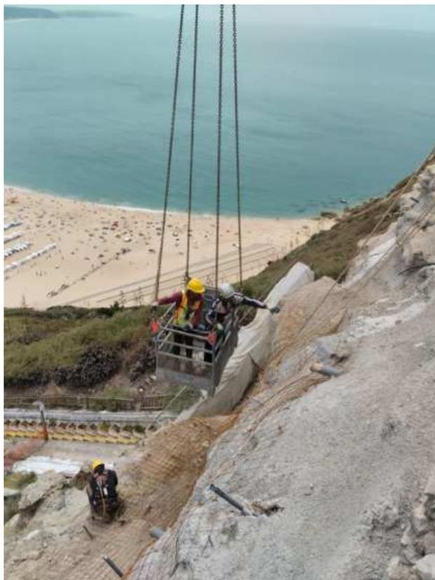
Foto 3 – Trabalhos de aplicação de rede malhasol no pano do talude
