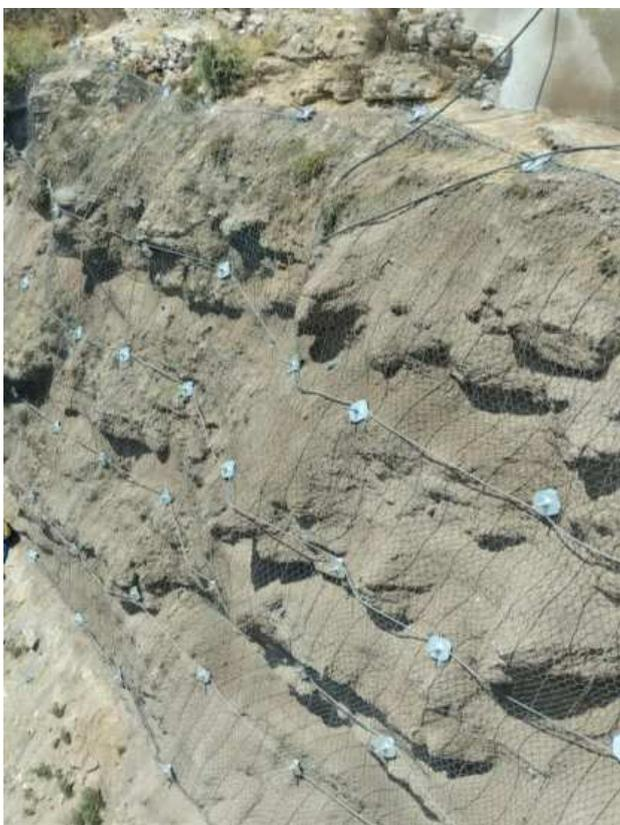
Foto 8 – Vista geral da solução de estabilização aplicada no pano talude
