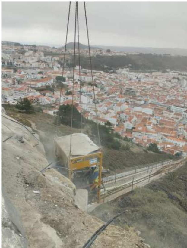
Foto 1 – Trabalhos de execução de furação de pregagens e drenos no pano do talude
