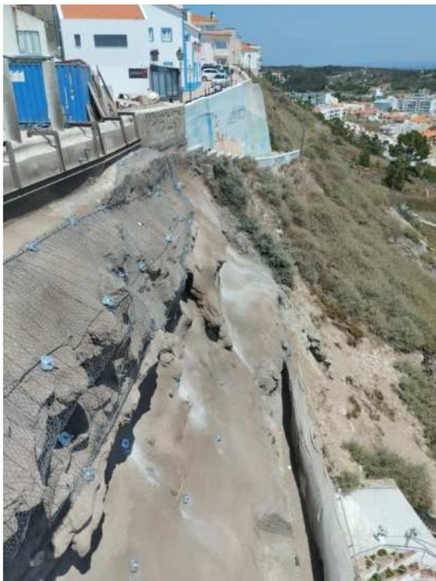
Foto 7 – Vista geral da solução de estabilização aplicada no pano talude
