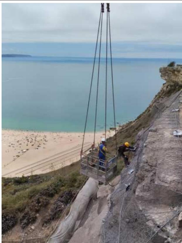
Foto 6 – Trabalhos de aplicação de redes e cabos de estabilização no pano do talude
