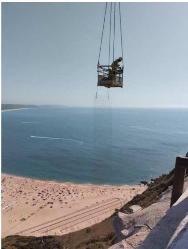
Foto 2 – Trabalhos de aplicação de rede malhasol no pano do talude
