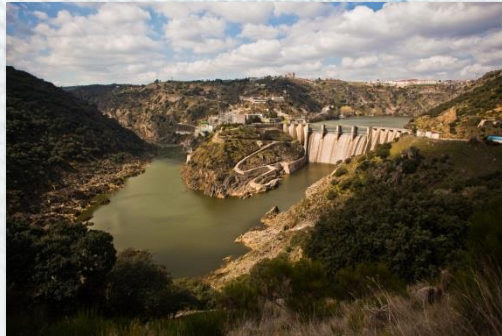
Barragem de Miranda (Fonte: APA/ARH Norte)
