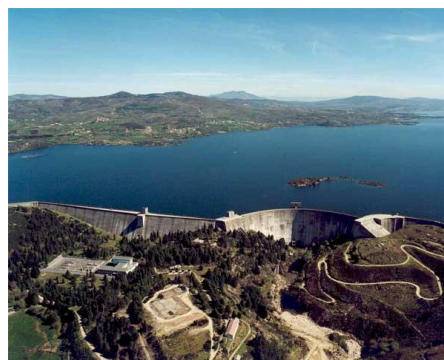
Barragem do Alto Rabagão (Fonte: APA, IP.)
