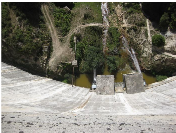
Barragem do Alto Rabagão (Fonte: APA, IP.)
