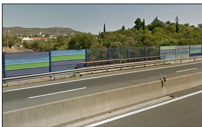
Figura 3 – Exemplos de barreiras acústicas de diversos tipos instaladas na Via do Infante
