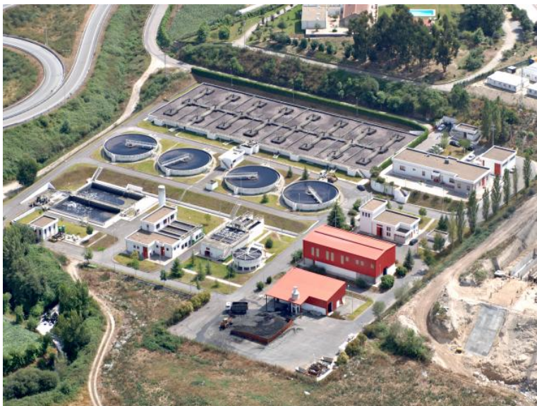
Figura 13 – Intervenção da Águas do Ave
