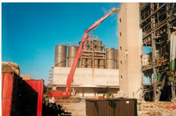
Local de demolição. Fonte: VERAS
