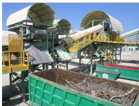
Estações de reciclagem de resíduos de C&D. Fonte: ANPAR
