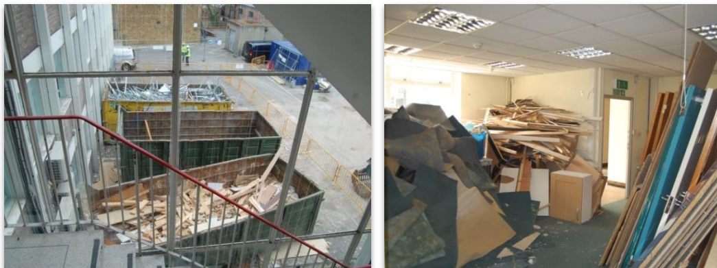
Separação na origem nos locais de demolição. Fonte: UEPG
