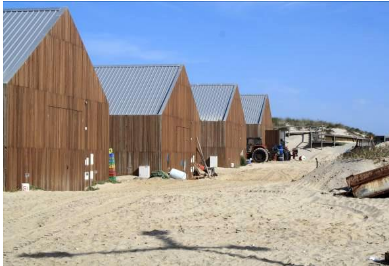
Figura 9 - Edifícios de apoio à arte xávega na praia de Mira.
