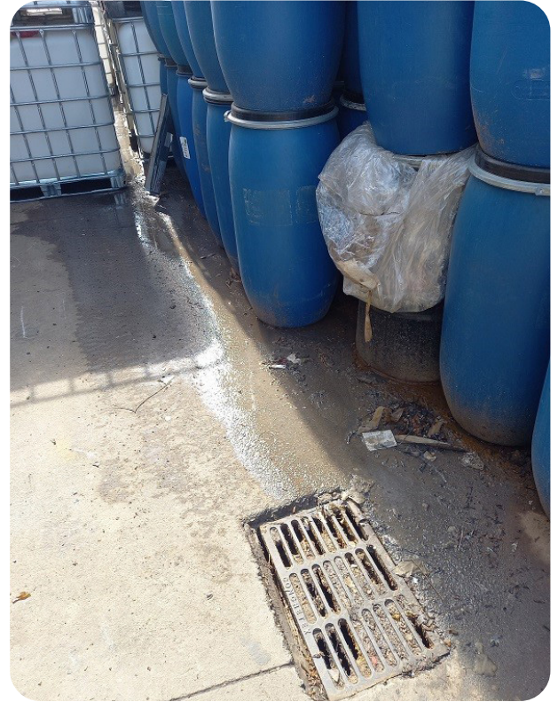
Armazenamento inadequado dos resíduos e escorrências de águas de lavagem para a rede pluvial
