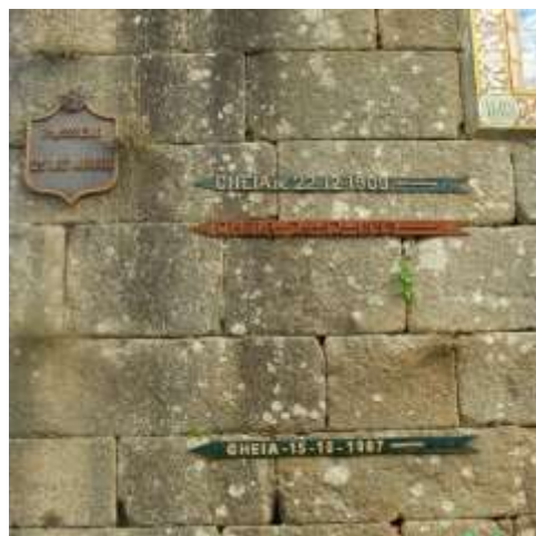
Figura 6. Elementos necessários à modelação hidrológica e hidráulica, medição de caudal e marcas de cheia
