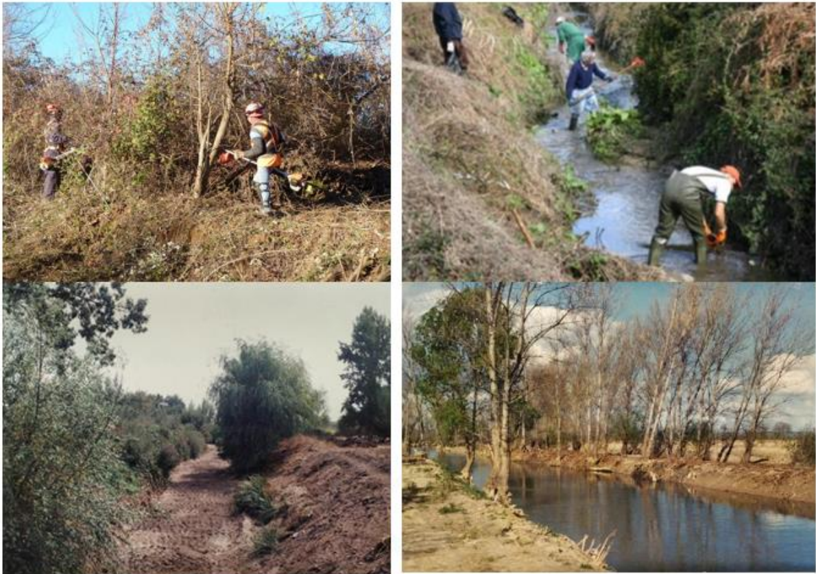
Figura 33 - Realização de ações de limpeza no âmbito da medida PT_PROT1_NAC
