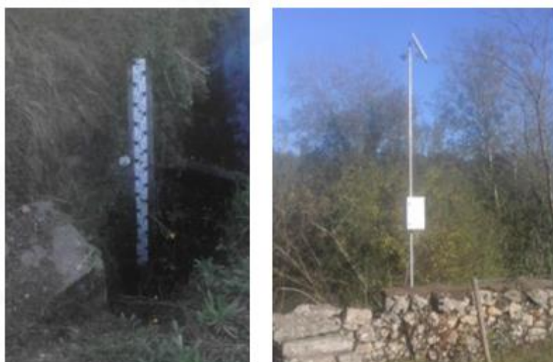
Figura 35 - Estação Hidrométrica Rabaçal
